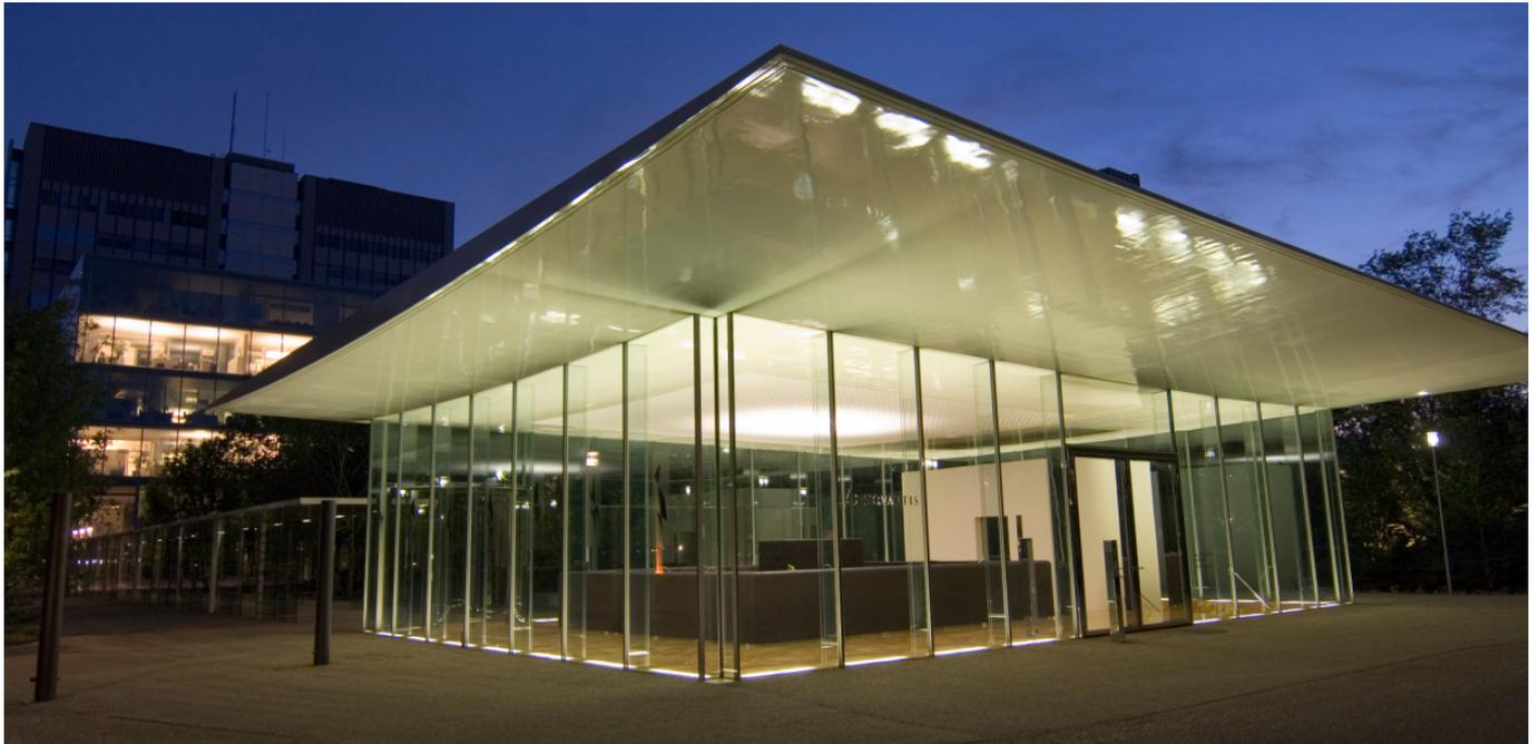
**Das Empfangsgebäude zum Novartis Campus in Basel ist eine Last abtragende Ganzglaskonstruktion. Sie hat ein flügelähnliches Dach aus glasfaserverstärktem Kunststoff.**
