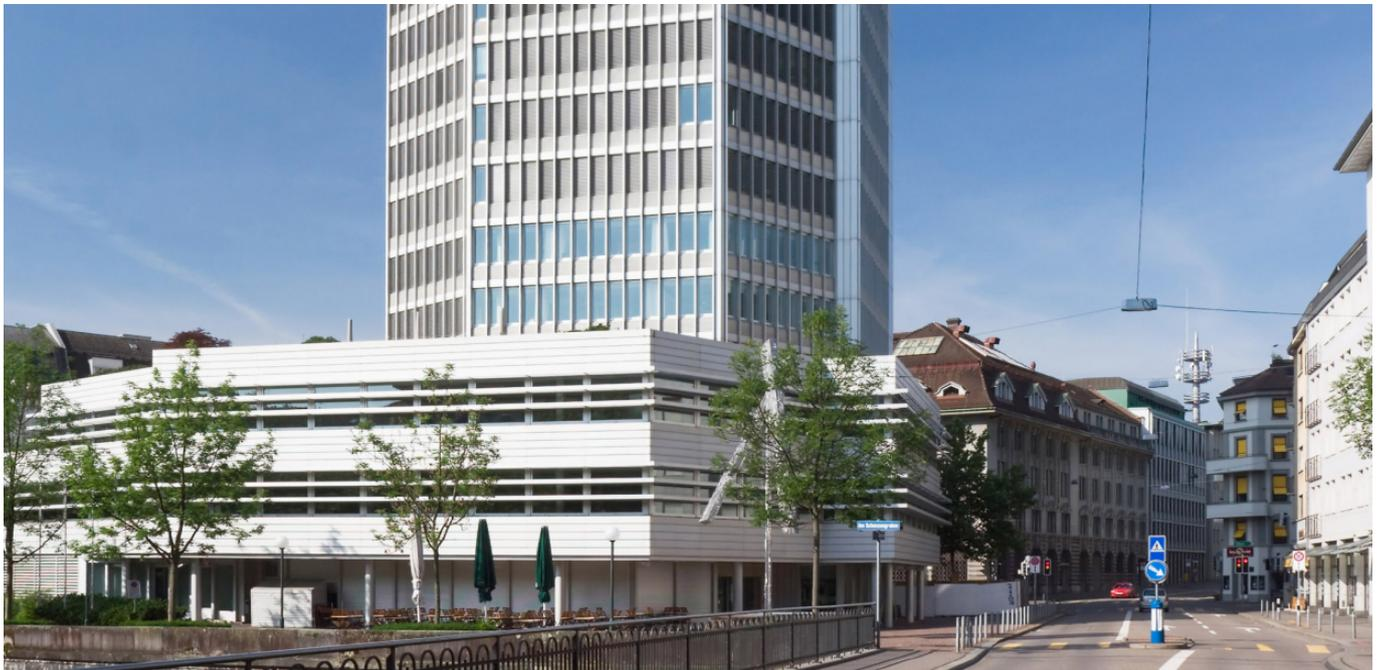
**2006 überprüfte EBP das Tragwerk des Hochhauses zur Schanzenbrücke in Zürich auf seine Erdbebensicherheit. 2020 wiederholten wir die Beurteilung. Zudem analysierten wir das Tragwerk (Durchstanzen, Brandschutz, Dichtigkeit) und die Bedingungen für allfällige Veränderungen am Bauwerk (Aufstockung, Ersatzneubau).**
