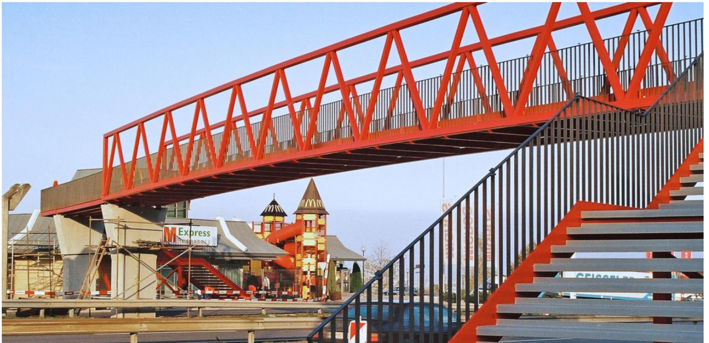
**Die Überführung für Fussgänger bei der Raststätte A3 Fuchsberg soll ersetzt werden. Herausforderung ist sowohl das Variantenstudium als auch eine Realisierung ohne Sperrung der Autobahn.**
