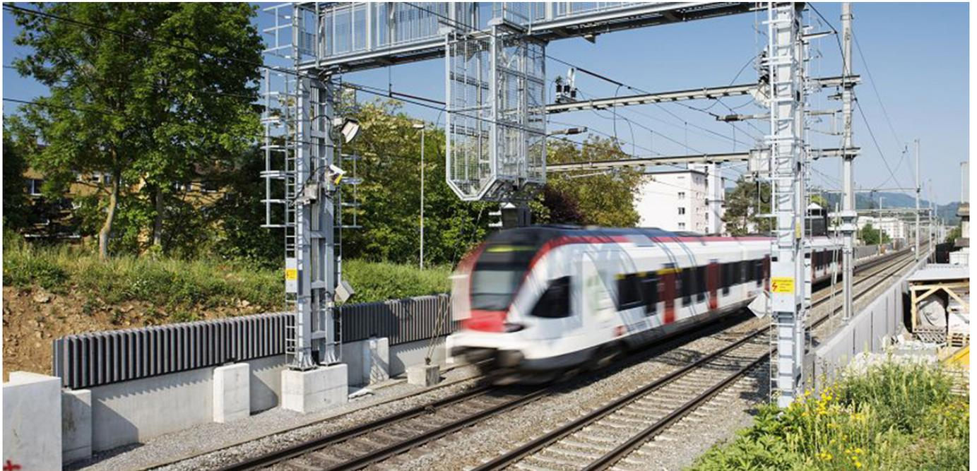
**An den Zugkontrolleinrichtungen werden zahlreiche Parameter an vorbeifahrenden Zügen gemessen. Mittels RFID können die Daten zuverlässiger als bisher den einzelnen Wagen und Achsen zugeordnet und die Daten für weitere Anwendungen genutzt werden. Ziel des Projektes ist es, den Nutzen einer Ausrüstung der ZKE mit RFID aufzuzeigen.**
