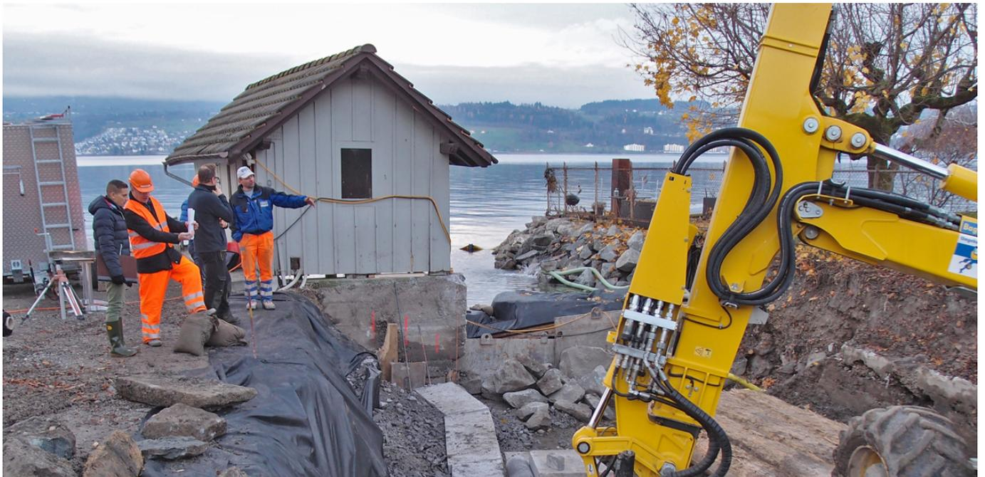
**Der eingedolte Grundbach wird auf 100 m Länge ausgedolt und renaturiert in den Zürichsee geführt. EBP entwickelte in einer Machbarkeitsstudie verschiedene Varianten, erstellte das Wasserbauprojekt und hat die Bauleitung inne.**
