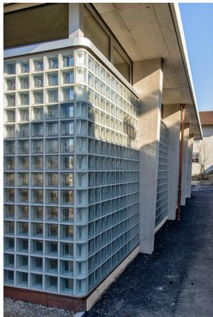
Bei der Turnhalle wurde die gleiche Architektur fortgeführt. Eine Ausnahme galt der Fensterfront: Grossformatige und vorgefertigte Glasbaustein-Wände sind unten auf Beton abgesetzt und seitlich in den Stützen befestigt. Oberhalb der Glasbausteinwände sind Oberlicht-Fensterbänder in Metall montiert, die sich zum Teil öffnen lassen. Der Neubau des Schulhauses errang den 1. Platz beim Architekturpreis des Kantons Zürich für das Jahr 2019.
