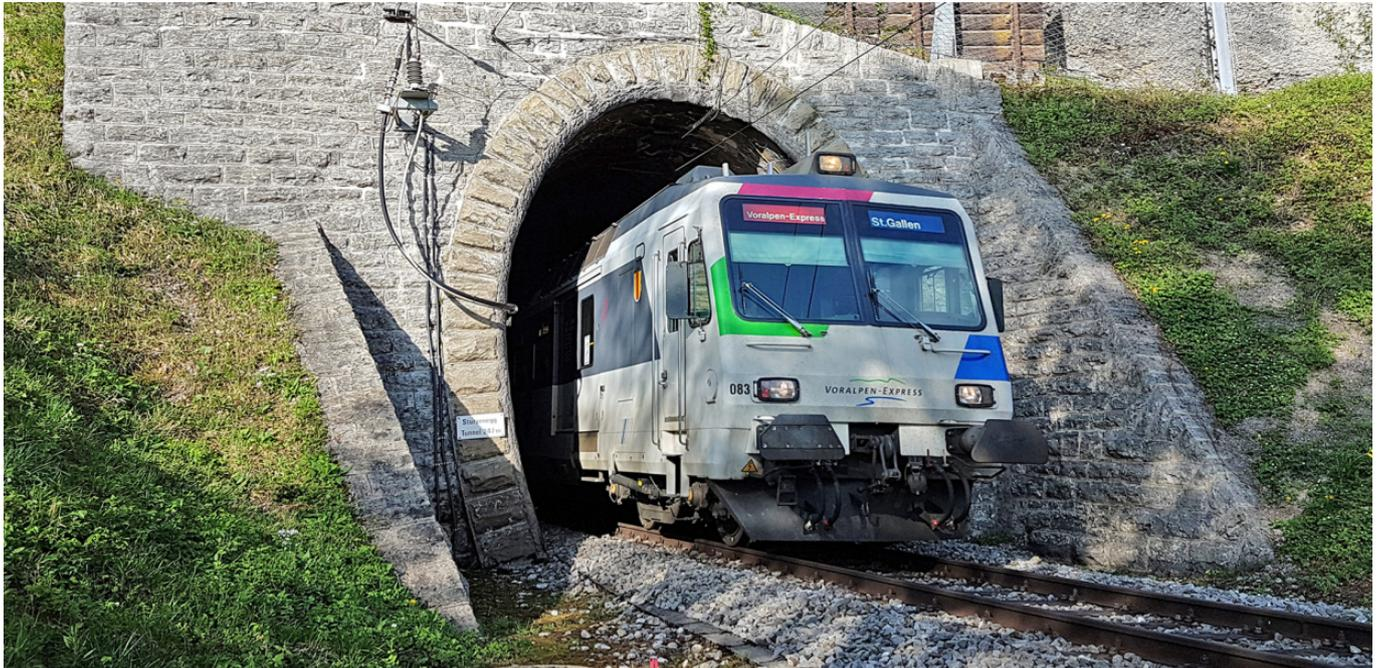
**Der Sturzenegg tunnel wurde 1910 erbaut. Die Schweizerische Südostbahn AG hat EBP damit beauftragt, die nötigen Erneuerungsmassnahmen zu planen. Sie sollen das erforderliche Lichtraumprofil, die langfristige Tragsicherheit und die Gebrauchstauglichkeit sicherstellen. EBP wird zudem die Bauleistungen submittieren und die Realisierung leiten.**
