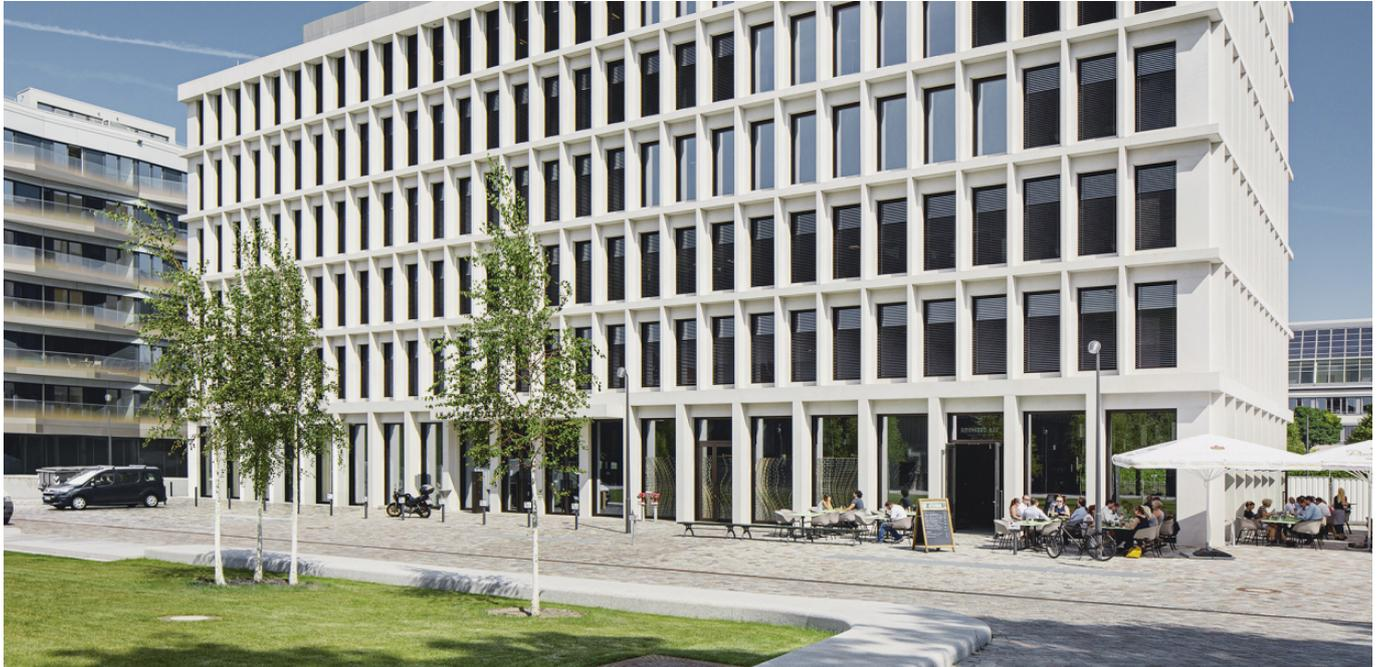
**EBP kann auch in Deutschland Fassaden planen, so im neuen eigenen Bürostandort in Berlin. Im Zentrum der Planungen standen die fugenlose und filigran geformte Ortbetonfassade sowie die dahinterliegende dichte Gebäudehülle. Die grösste Herausforderung: die dichte Gebäudehülle sicherzustellen, obwohl zum Zeitpunkt der Montage innen der Rohbau und aussen die Betonfassade bereits vorhanden waren.**
