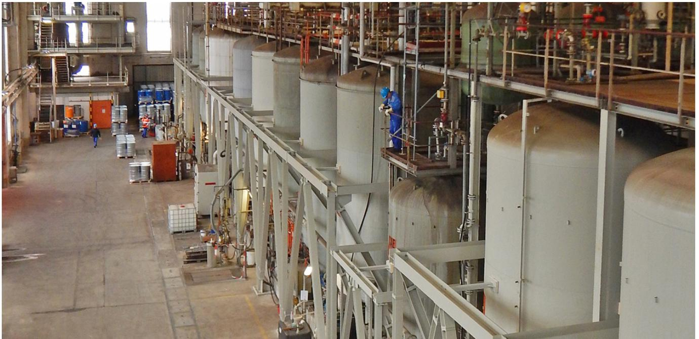
**EBP analysierte für die CABB die Erdbebensicherheit ihrer Stahltanks, in denen Gefahrgüter lagern. Zudem projektieren wir die nötigen Ertüchtigungsmassnahmen, welche bei laufendem Betrieb ausgeführt werden sollten.**
