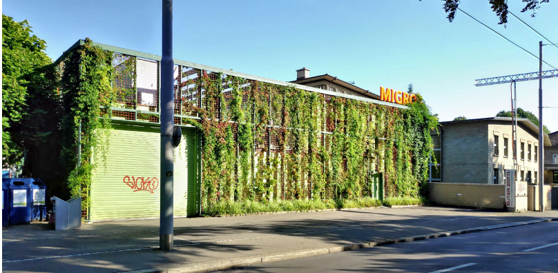
Begrünte Fassade kühlt die warme Luft des Strassenraums (Provisorium Migros Kreuzplatz; Quelle: EBP, 2019)
