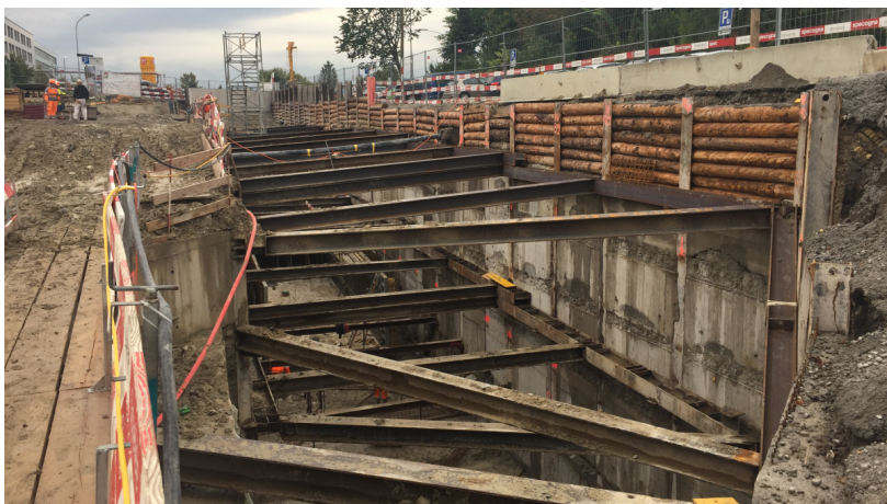
Baugrube Verbindungstunnel
