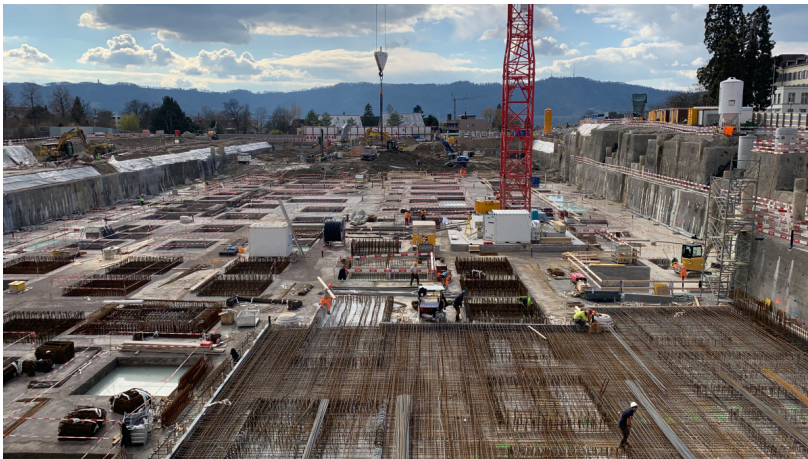
Baugrube Akutspital 1 - Bildquelle EBP
