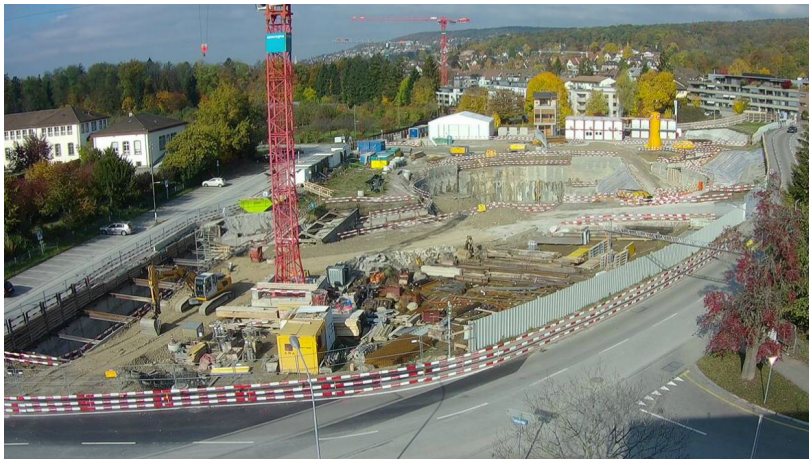
Baugrube Forschungsgebäude 2 - Bildquelle Webcam der Bauherrschaft
