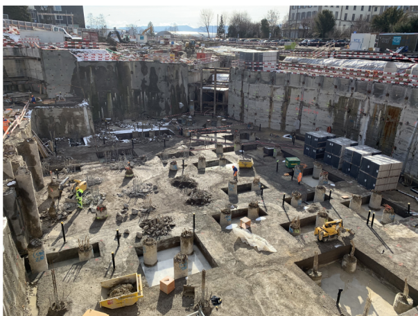
Baugrube Forschungsgebäude 1 - Bildquelle EBP
