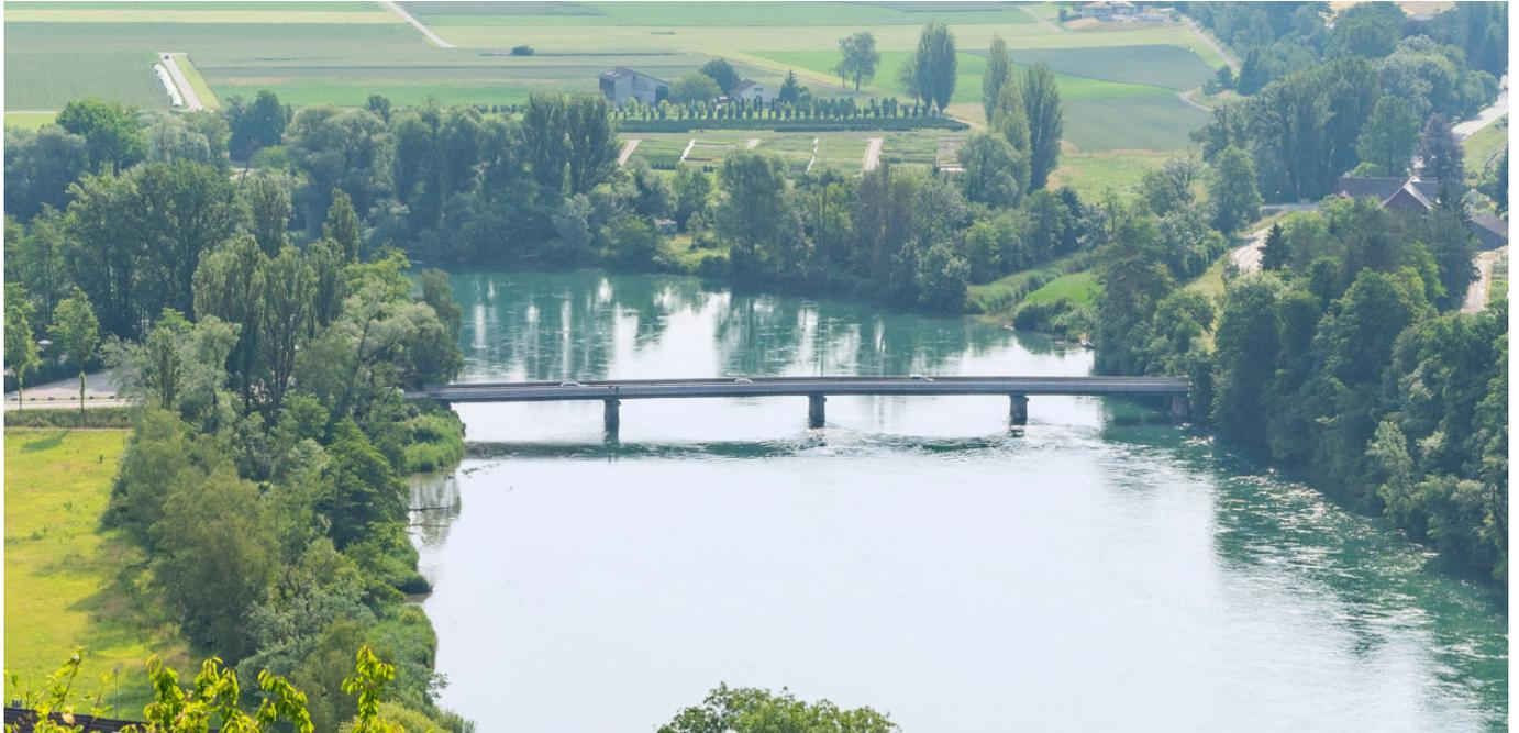
**Die Rheinbrücke Flaach ist Träger der Kantonsstrasse sowie von Wander- und Radwegen über den Rhein zwischen Flaach ZH und Rüdlingen SH. Das bestehende Bauwerk weist altersbedingt diverse Schwachstellen auf, was einen Ersatz fordert.**
