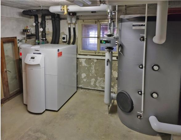
Neue EWS Wärmepumpe im Altbau anstelle Gasheizkessel
