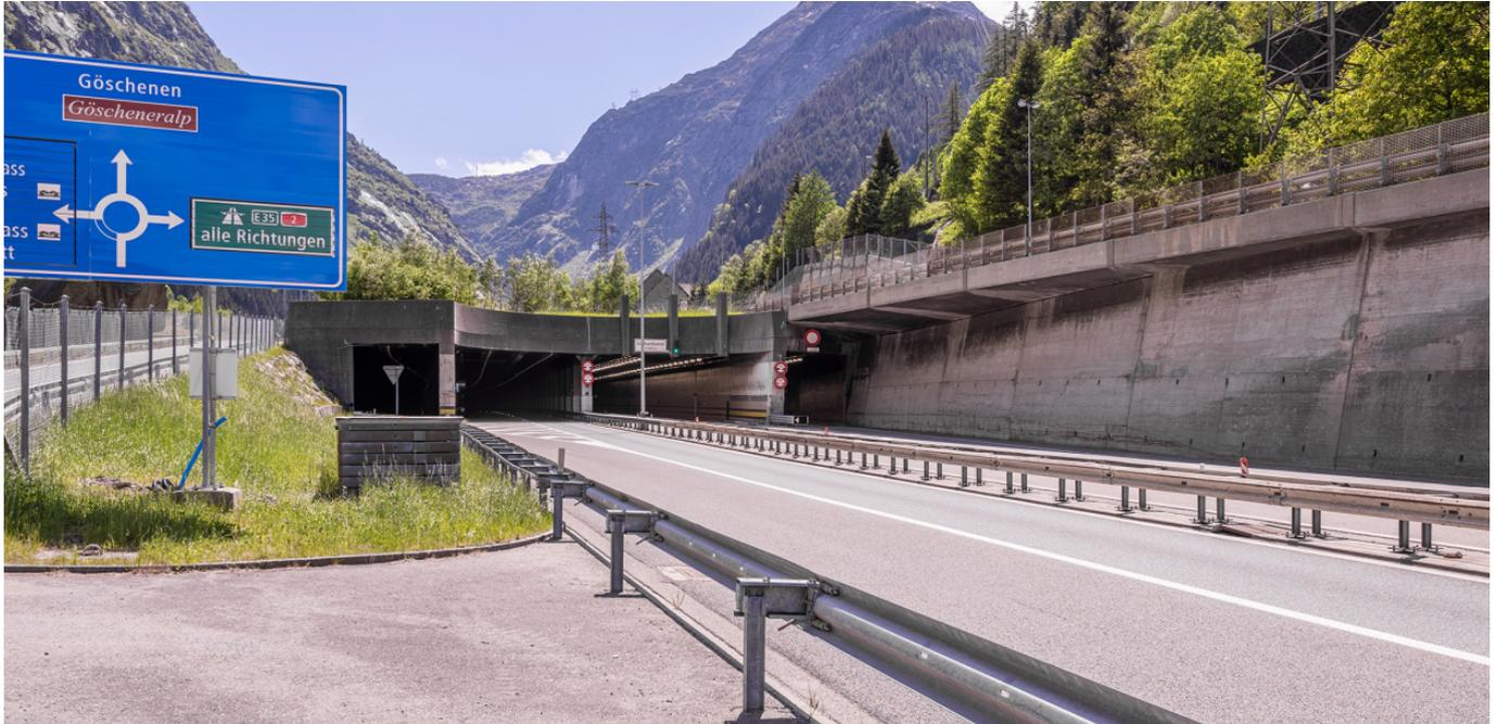
**Die Volksabstimmung vom 28. Februar 2016 bestätigte den Bau einer zweiten Röhre des Gotthard-Strassentunnels 70 Meter neben der bestehenden ersten Röhre, welche anschliessend saniert wird.**
