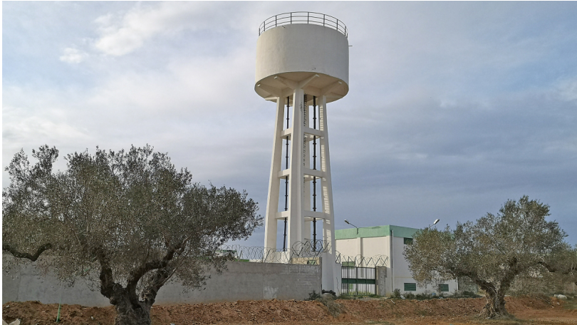
Wasserturm zur Speicherung und Verteilung von gereinigtem Abwasser an die Landwirtschaft
